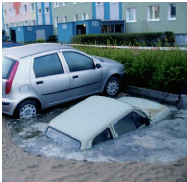
Рис.1. Последствия утечки на водопроводе
